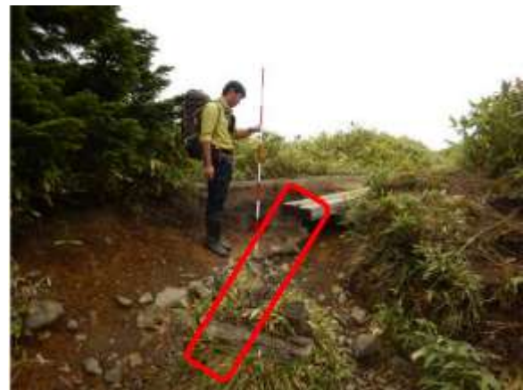
写真10 本道の消失による段差の発生
