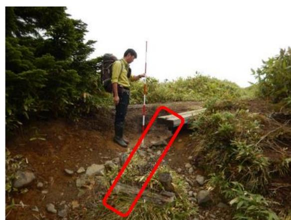
写真10 本道の消失による段差の発生
