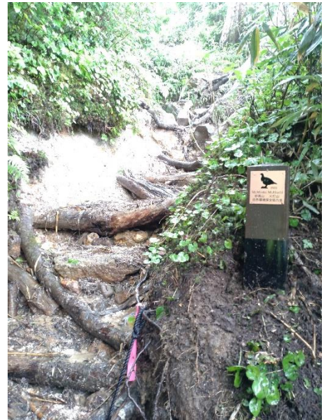
写真 27 近自然工法による登山道整備
